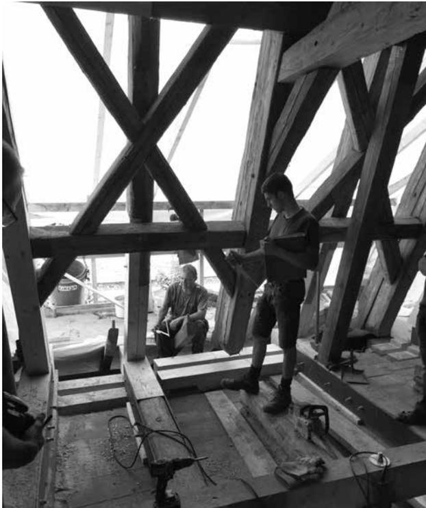
*In Graitschen gehen die Sanierungsarbeiten an der Dachkonstruktion der Kirche dank der Zimmerer der BEYER Ing. -Holzbau GmbH & Co. KG Dittersdorf gut voran.*
